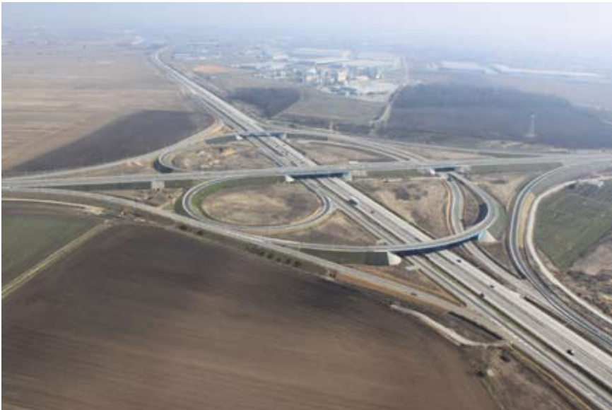
Autostradowa Obwodnica Wrocławia
